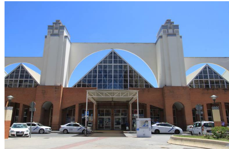
Estación del Paseo de Los Tilos
