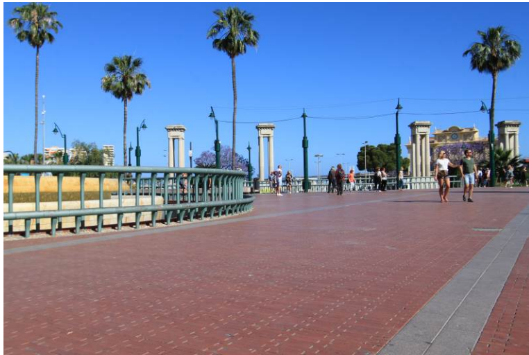
La rasante actual impide ver la lámina de agua
